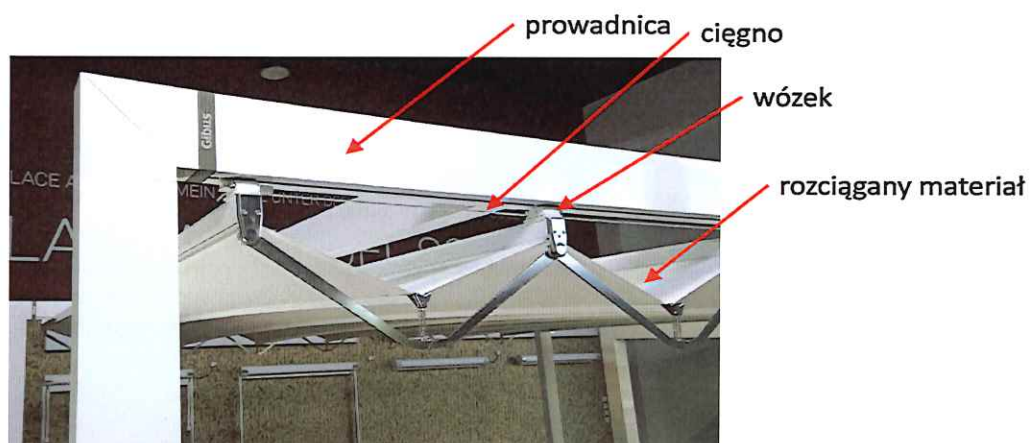
Rys. 2.2 Główne elementy składowe zadaszzenia
