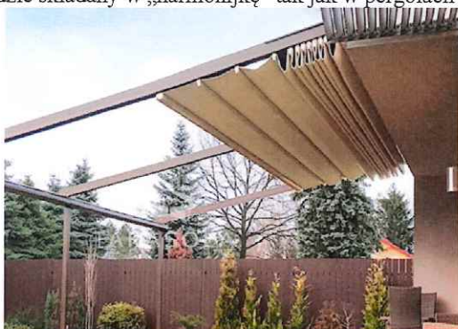
Rys. 2. Ilustracja przyjętego sposobu składania materiału markizy.
